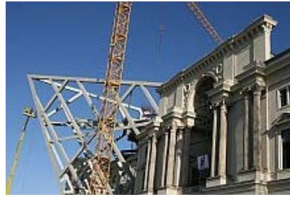
Der "Keil"-Rohbau durchdringt das alte Armeemuseum (Quelle: Bundeswehr/Jankowsky)
